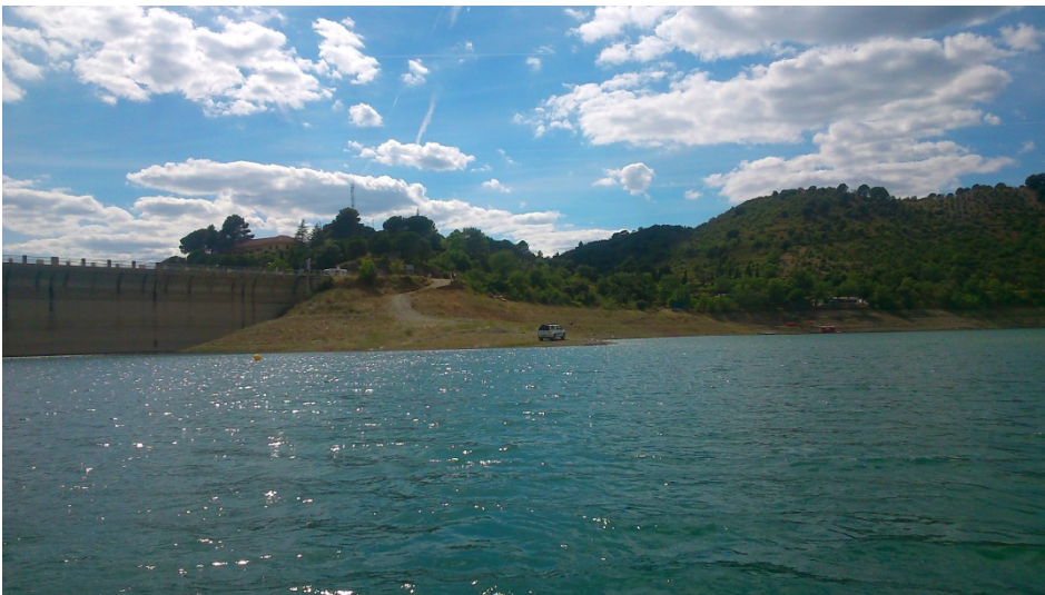
Figura 8. Vista del punto de acceso al embalse
