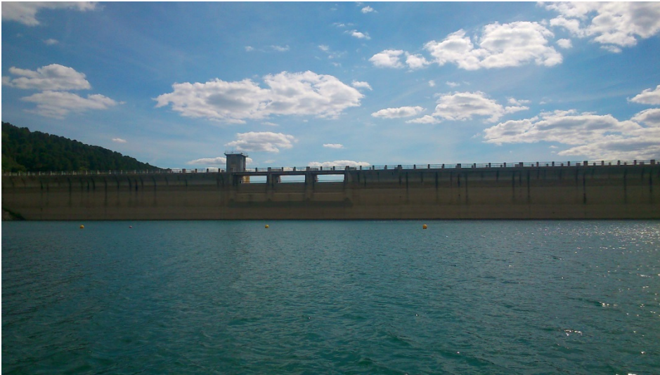
Figura 7. Vista de la presa del embalse
