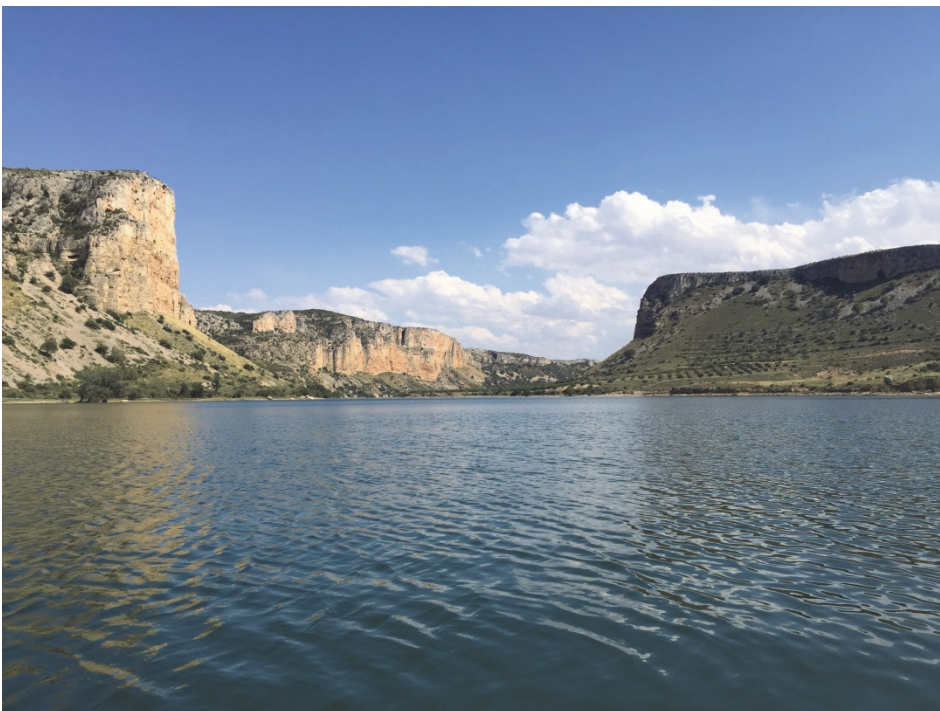
Figura 8. Vista de la cola del embalse
