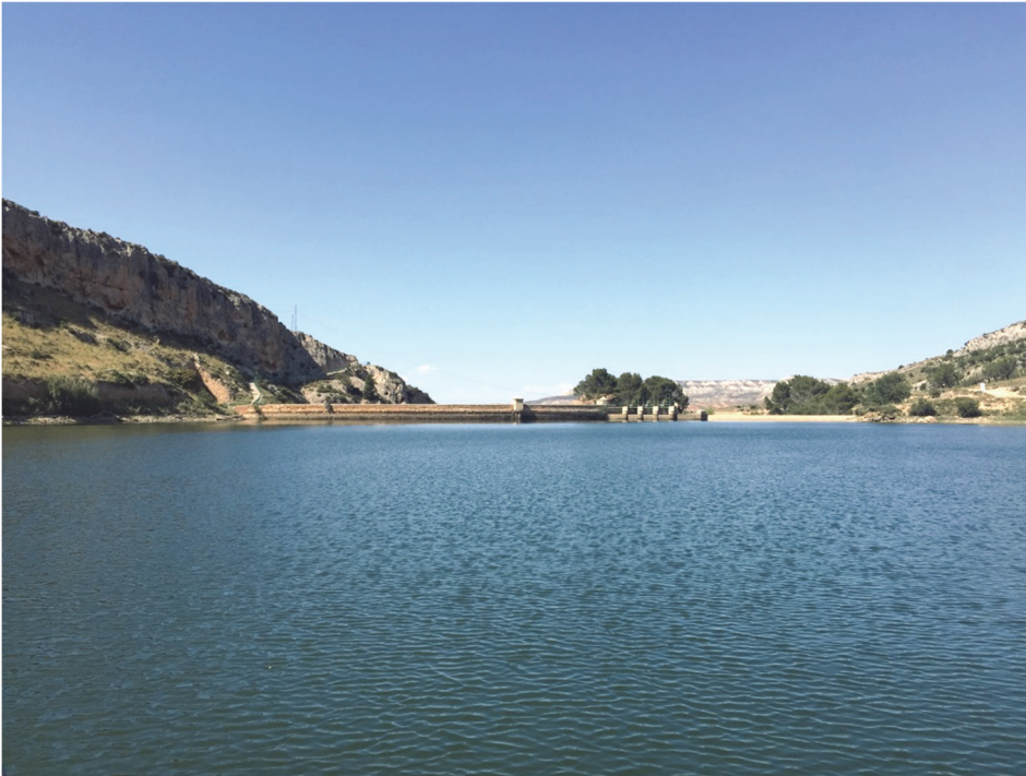
Figura 7. Vista de la presa del embalse
