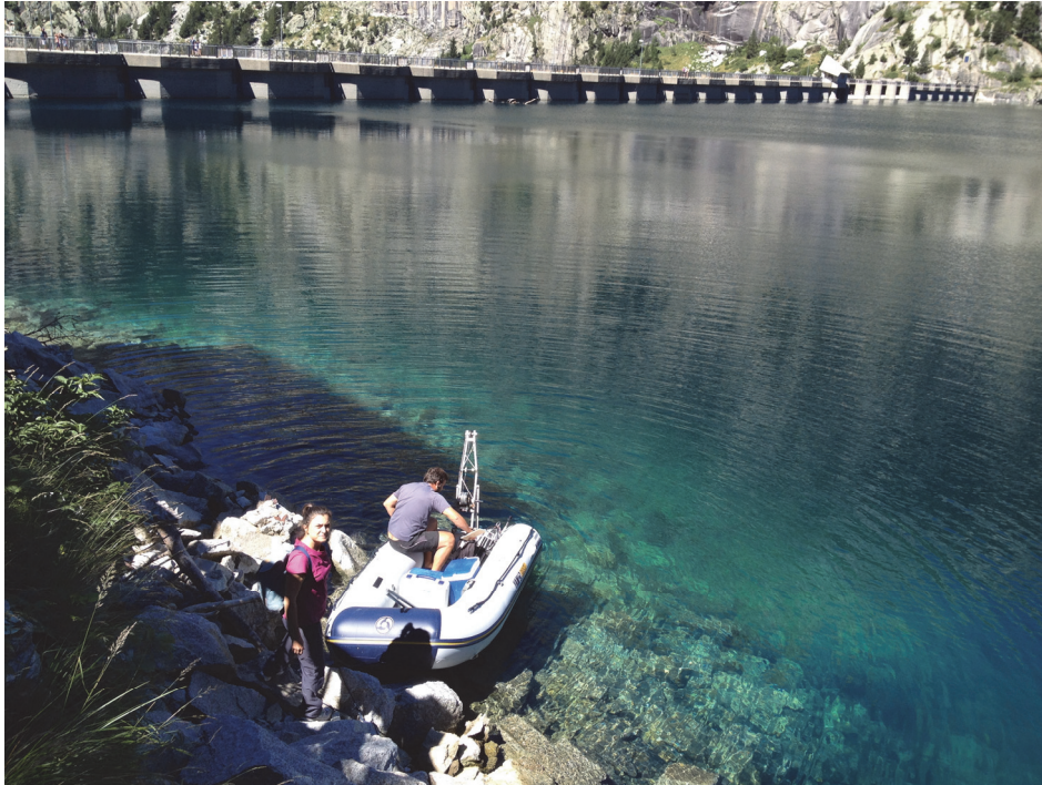
Figura 7. Vista del punto de acceso al embalse
