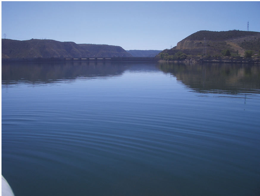
Figura 8: Vista de la presa del embalse
