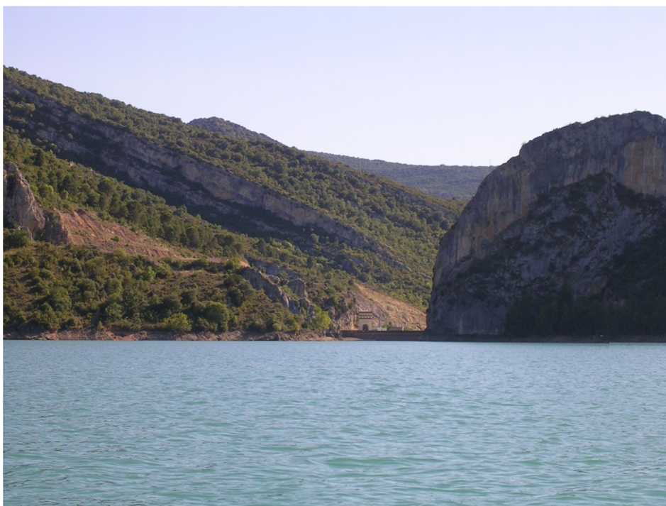
Figura 7. Vista de la presa del embalse
