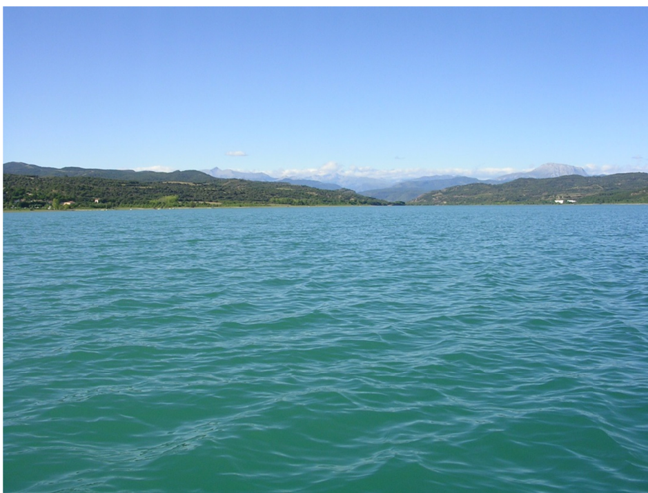
Figura 8. Vista de la cola del embalse
