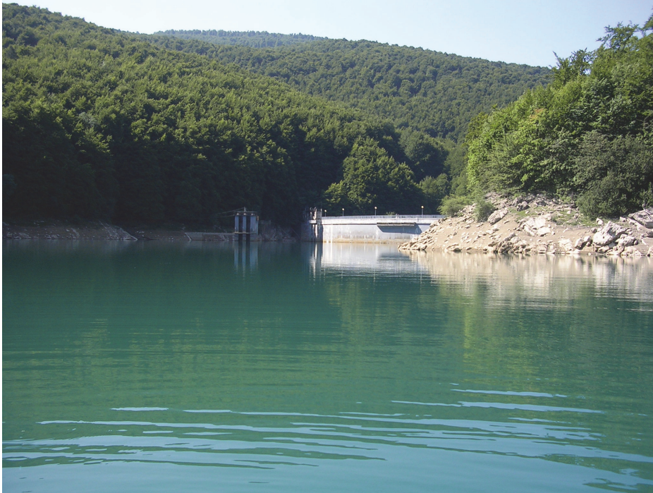
Figura 7: Vista de la presa del embalse
