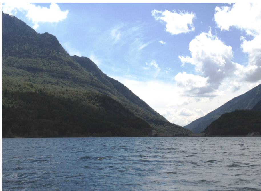
Figura 7. Vista de la presa del embalse
