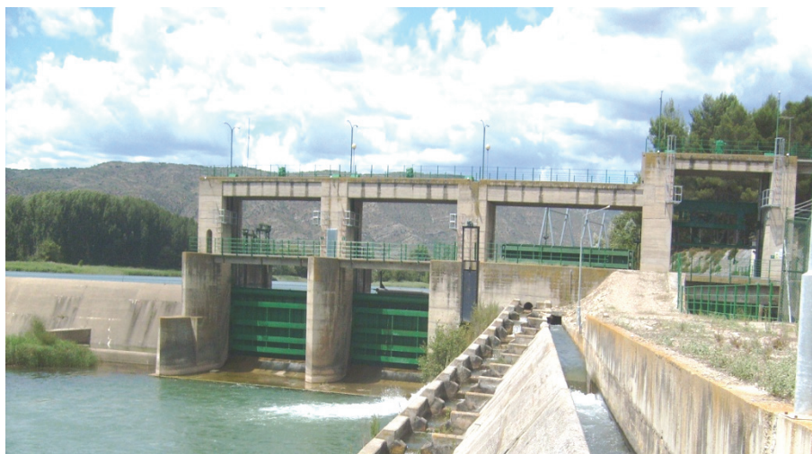
Foto 1: Presa del embalse de Balaguer
