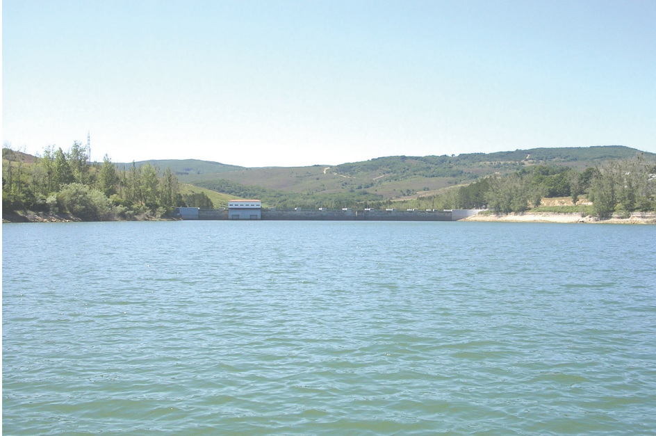
Figura 7: Vista de la presa del embalse
