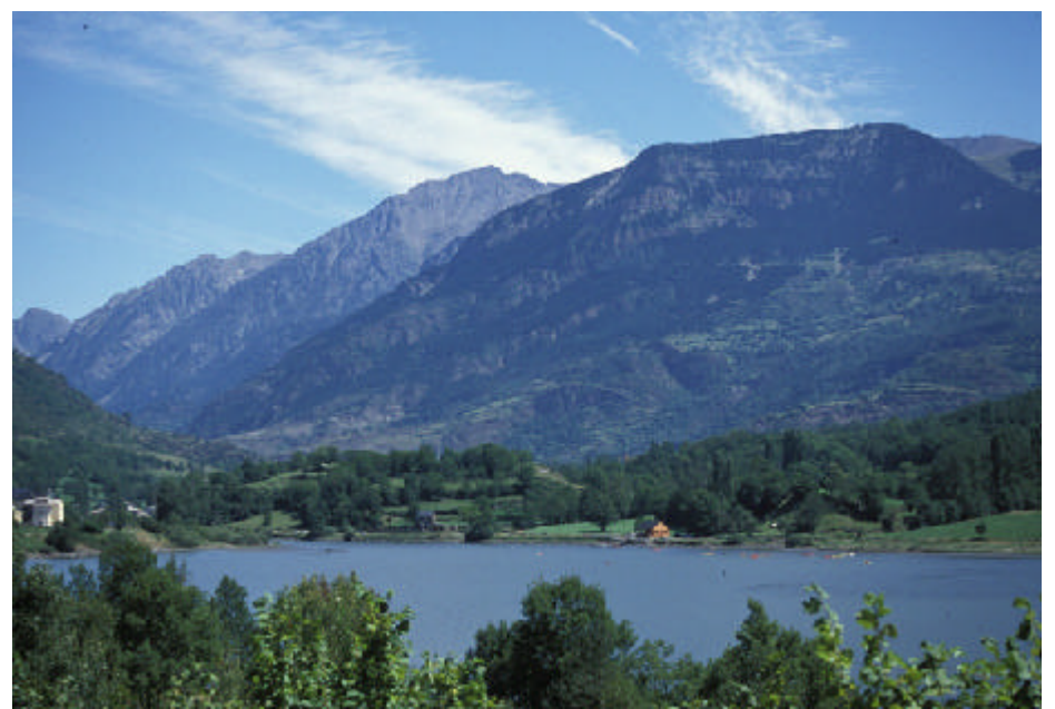
Foto 3.- Presa de Linsoles. Se trata de una presa de gravedad con dos aliviaderos de superficie. Este embalse tiene variaciones de nivel moderadas a lo largo del año y sufre acumulaciones de sedimentos que lo colmatan.
