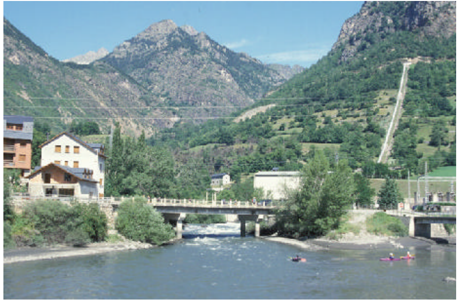
Foto 1.- Río Eriste y efluente de la central de Eriste en su desembocadura en el embalse de Linsoles, junto al pueblo del mismo nombre. El agua de la central procede principalmente del embalse de Paso Nuevo.
