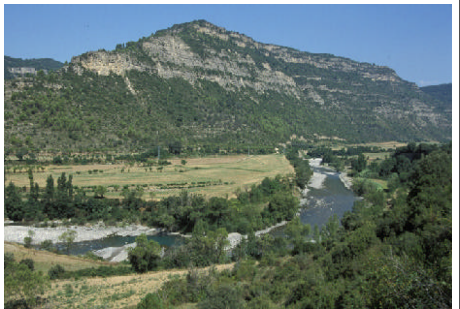
Foto 3.- Ésera en Graus. Una mota de hormigón de 300 m de longitud, en el margen izquierdo, protege las casas cercanas al cauce de posibles avenidas. También se observan los restos de pilas de un antiguo puente de piedra.
