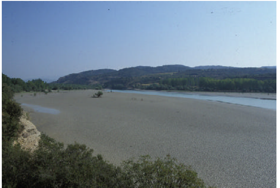
Foto 2.- Embalse de Joaquín Costa (Barasona). Existen extensas zonas poco profundas donde se produce una gran deposición de sedimentos, sobre todo en la cola del embalse.
