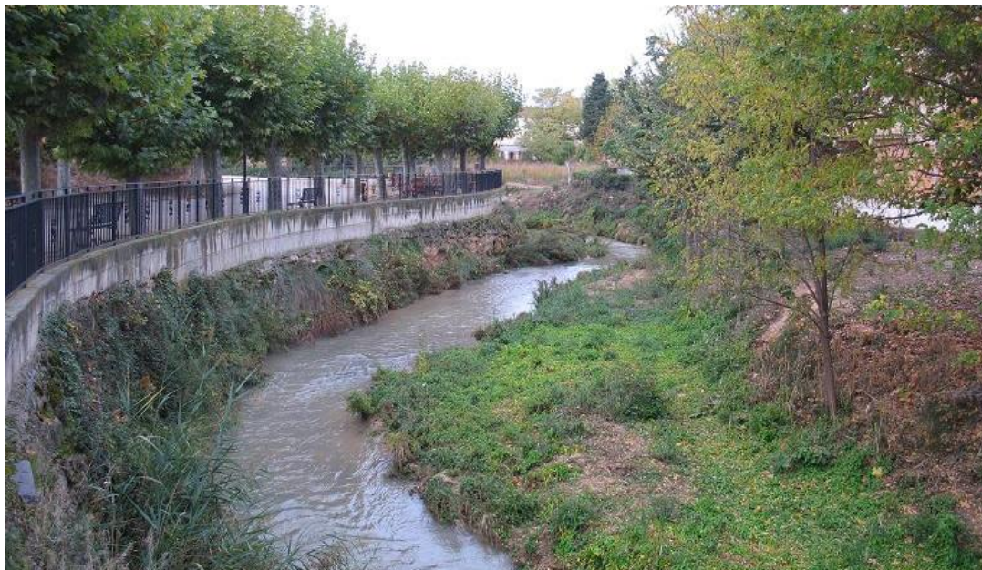
Figura 32-5. Río Jalón en Santa María de Huerta. Canalización y ribera muy alterada.
