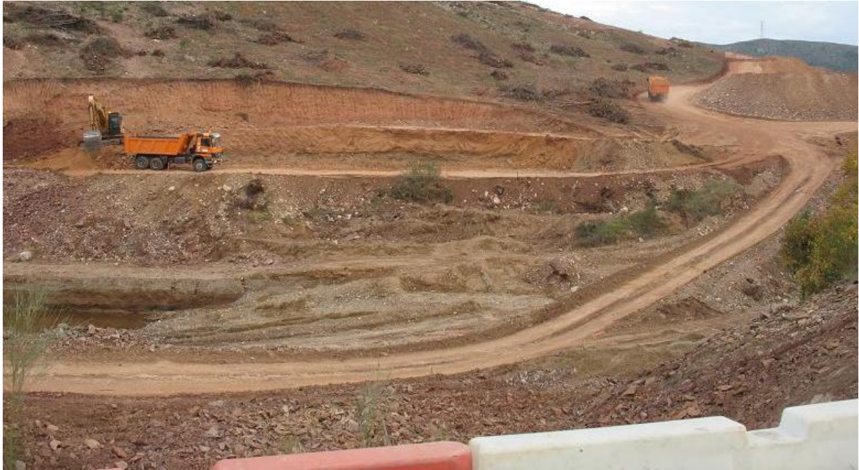
Figura 32-45. Obras del embalse de Mularroya en la parte baja del cauce del río Grío.
