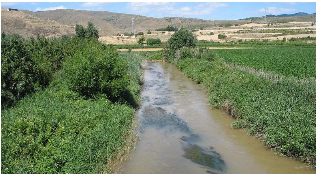
Figura 32-20. Cauce rectificado y dragado y zonas de ribera muy alterada aguas arriba de Huérmeda.
