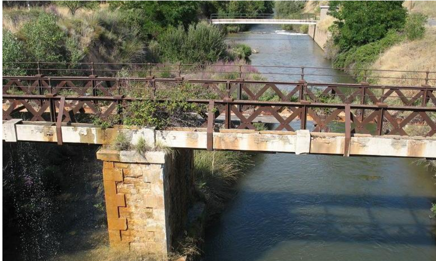
Figura 32-12. Estación de aforos del río Jalón en Ateca.
