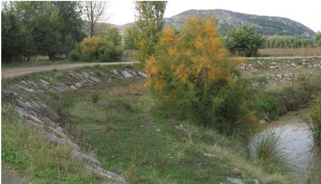
Figura 32-8. Defensas laterales en el río Jalón aguas abajo de Alhama de Aragón. Corredor ribereño muy alterado.
