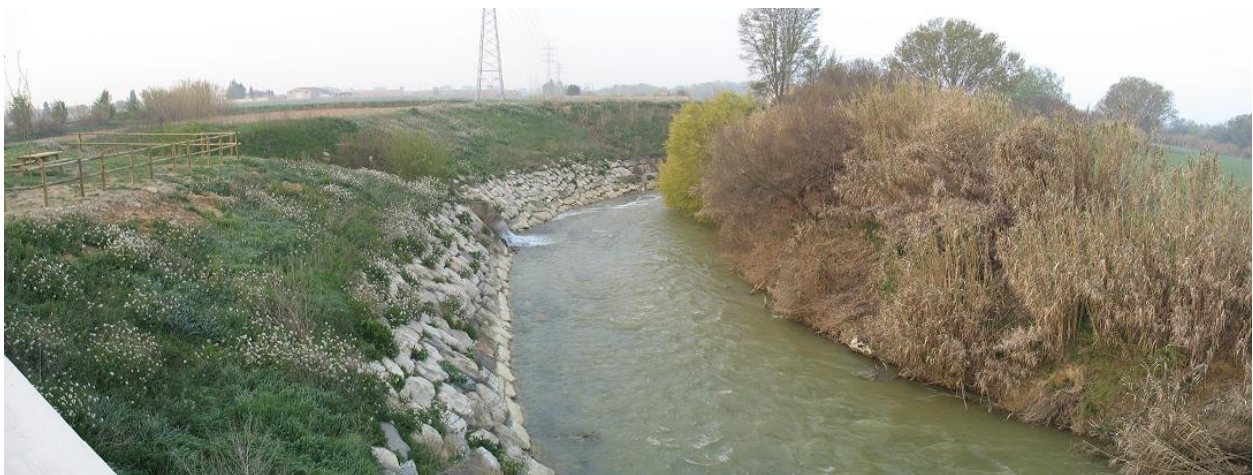
Figura 20-18. Defensas de margen en el río Arba de Luesia en el sector del núcleo de Tauste.
