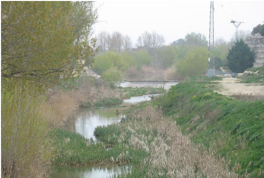
Figura 20-15. Azud de derivación aguas abajo de la localidad de Ejea de los Caballeros.
