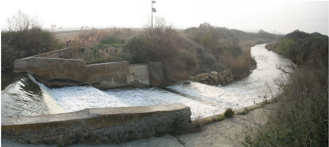
Figura 20-28. Derivación de caudales en el río Arba de Riguel en las inmediaciones de El Sabinar.
