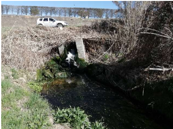
Vertido de la EDAR de Barbastro.
