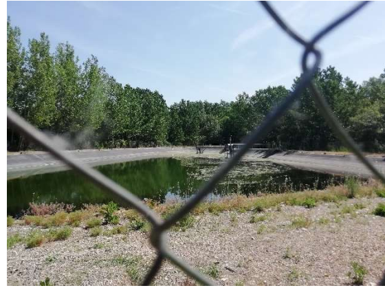
Balsa de depuración de Bodegas Pirineos.
