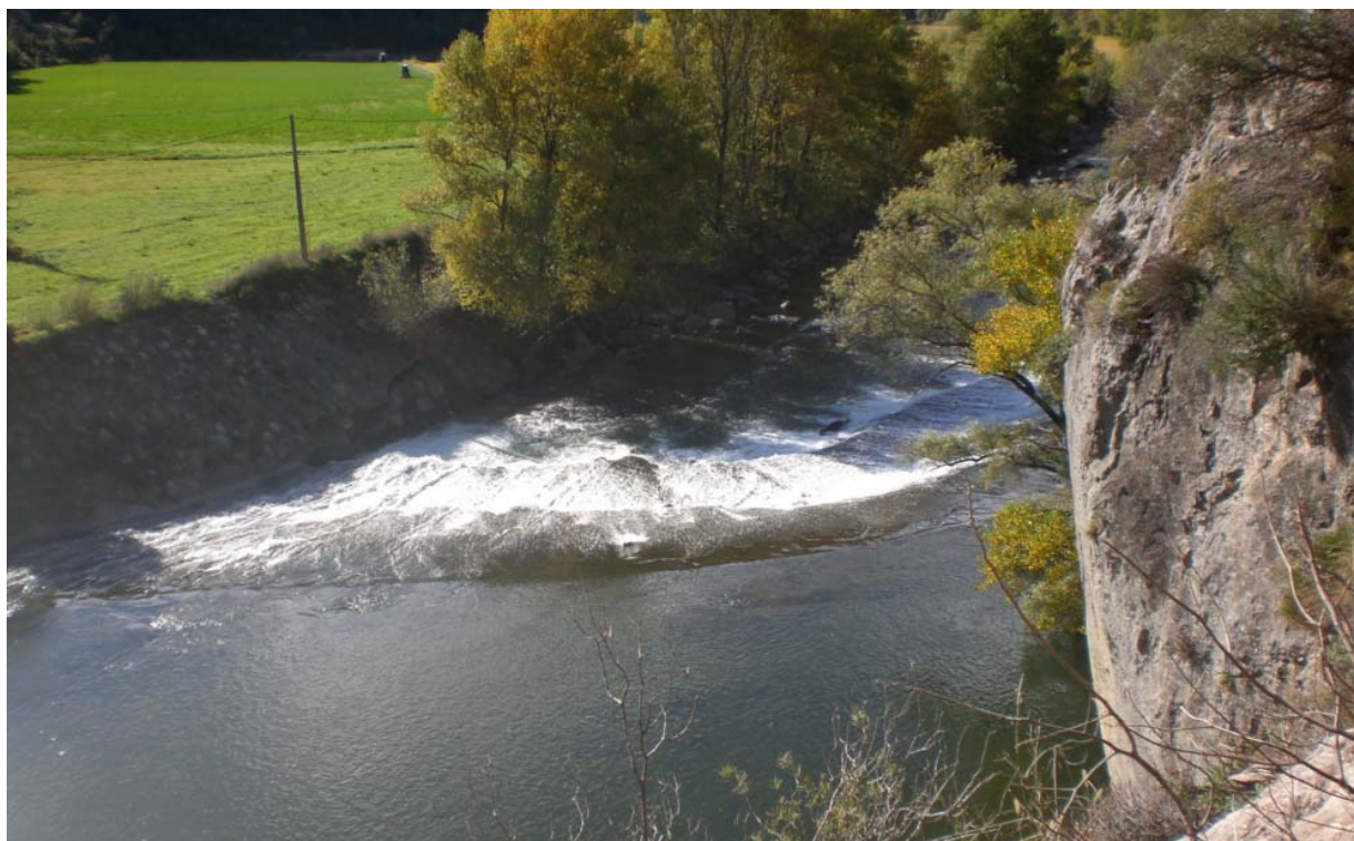
Fig. 6. Vista de la estructura desde aguas arriba
