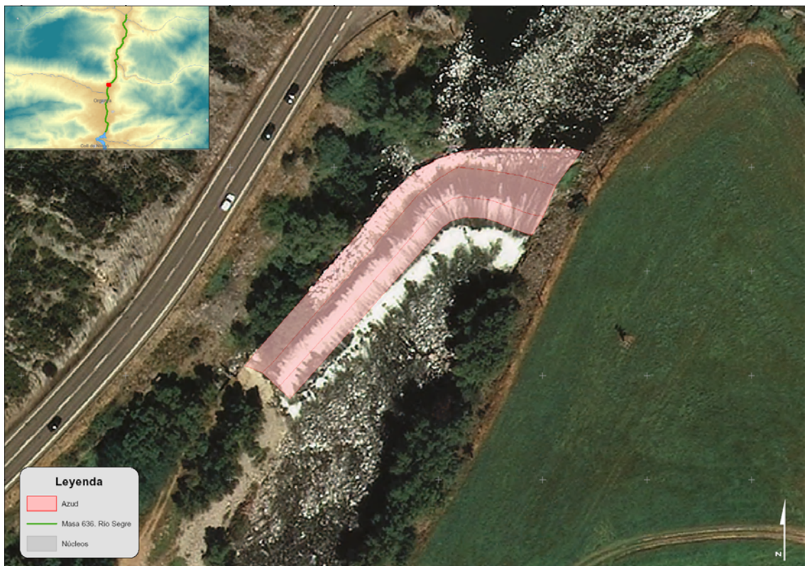
Fig. 7. Vista en planta del azud de derivación
