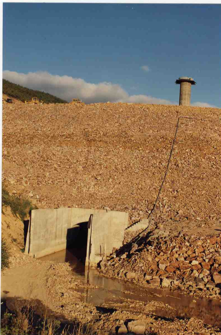
Foto nº 124 Presa de Pajares. Desagüe de fondo.
