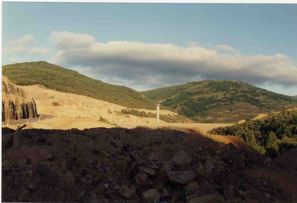
Foto nº 120 Presa de Pajares en construcción. (Julio 1991).
