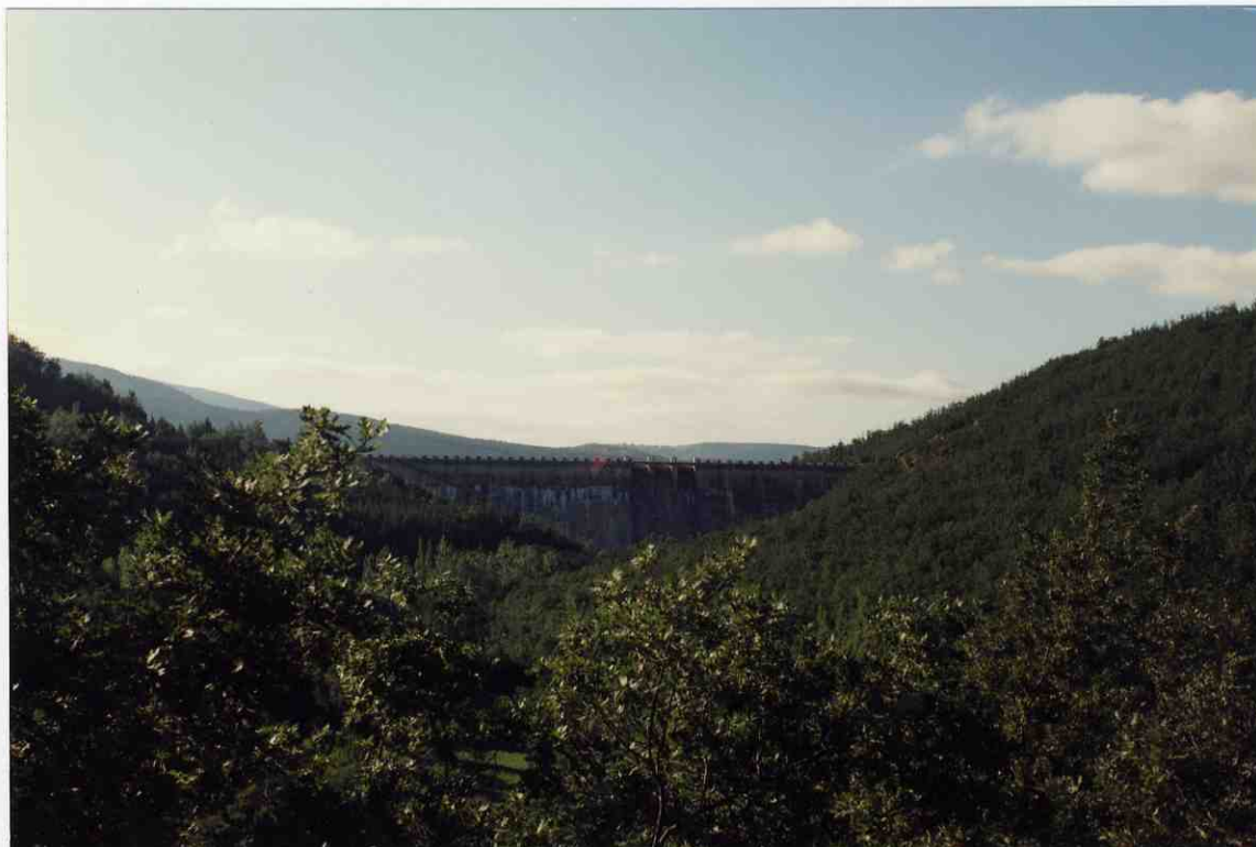
Foto nº 115 Presa de Ortigosa.
