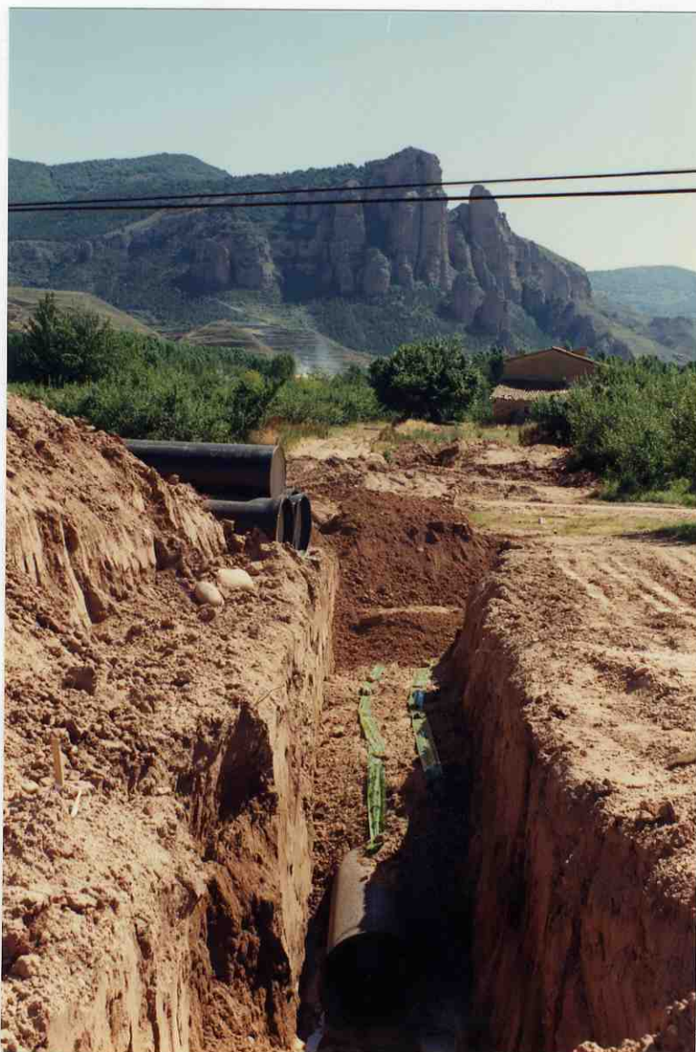
Foto nº 125 Trabajos del colector del bajo Iregua. T.M. Nalda
