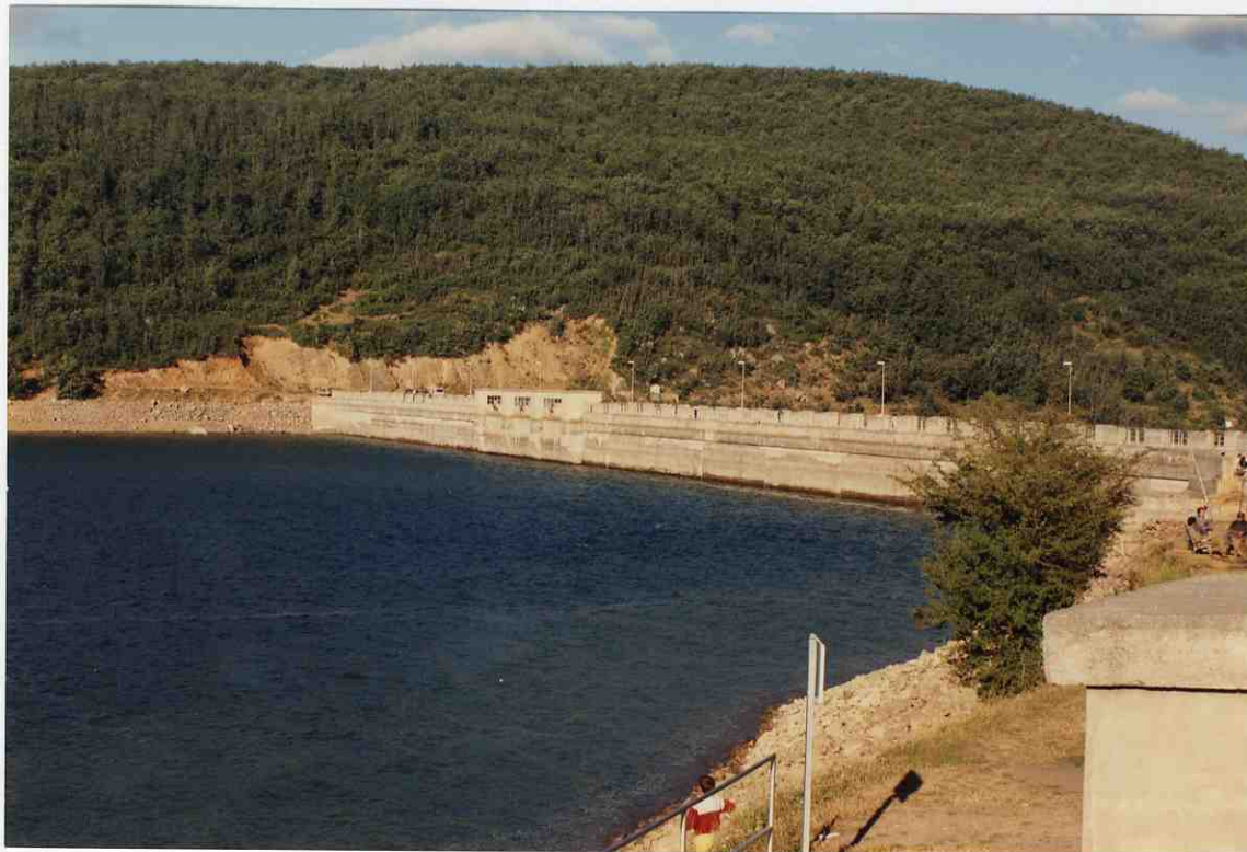
Foto nº 116 Presa de Ortigosa.
