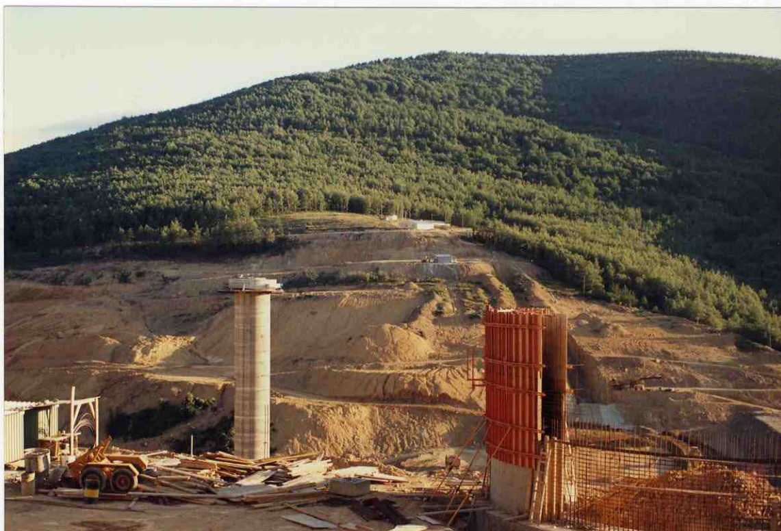
Foto nº 122 Presa de Pajares en construcción.
