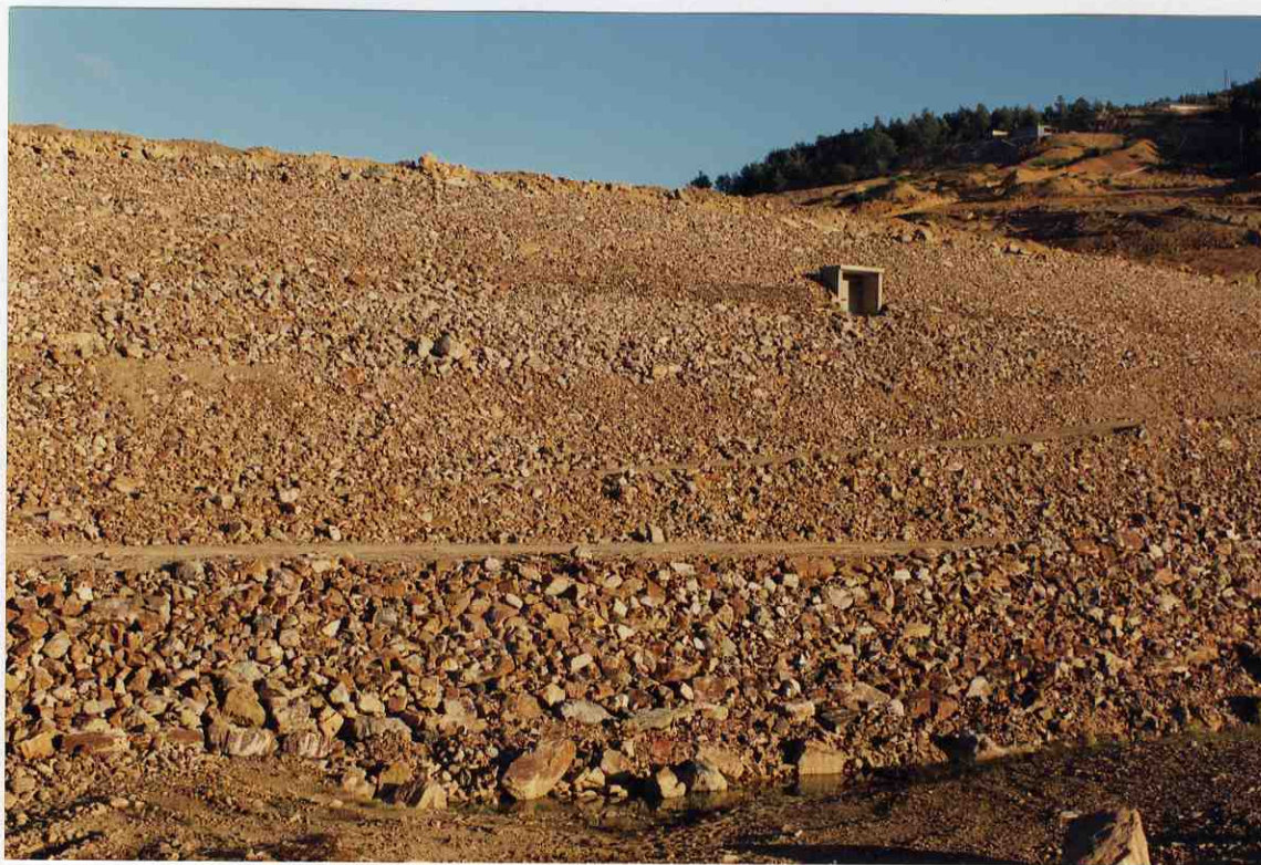
Foto nº 121 Presa de Pajares en construcción (Julio 1991)
