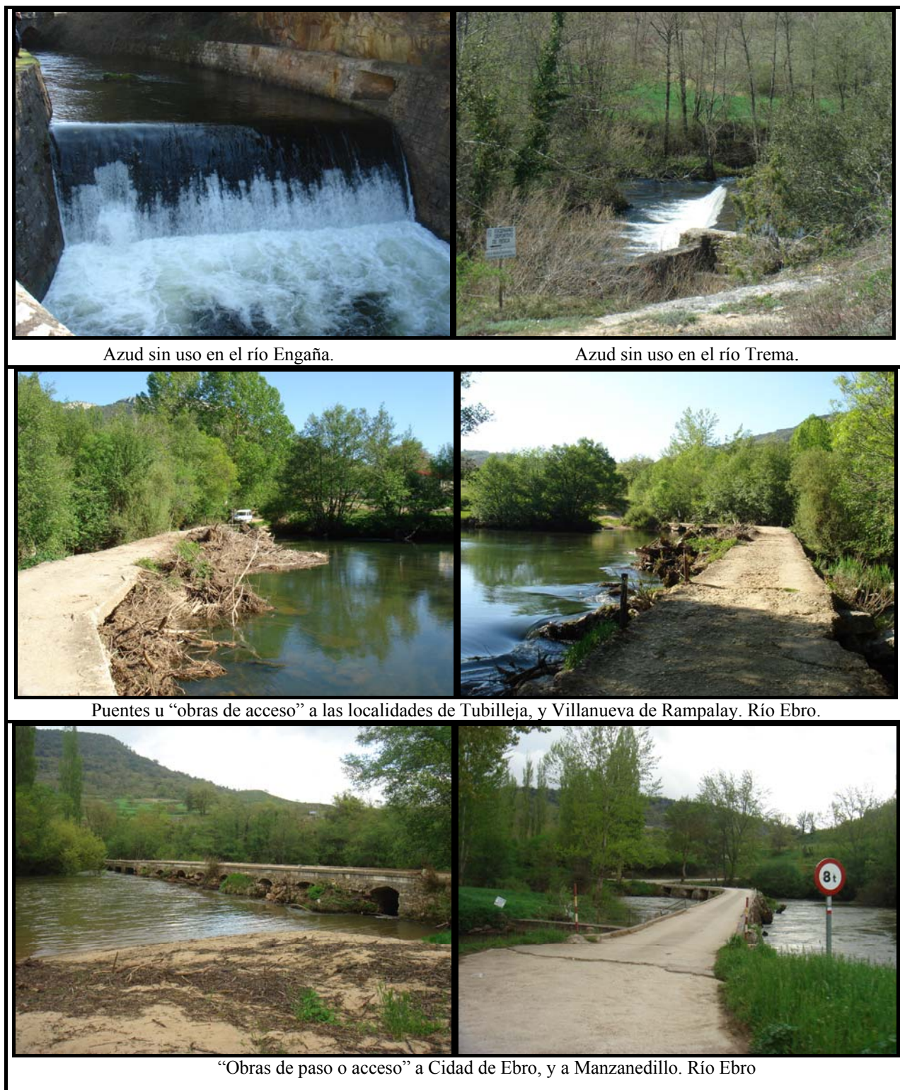
Figura 39: Algunos de los numerosos ejemplos existentes en la zona de la cuenca del Ebro en estudio; azudes sin uso alguno, obras de paso antiguas en mal estado y nuevas proyectadas erróneamente, e invasiones de cauces en zonas urbanas.
