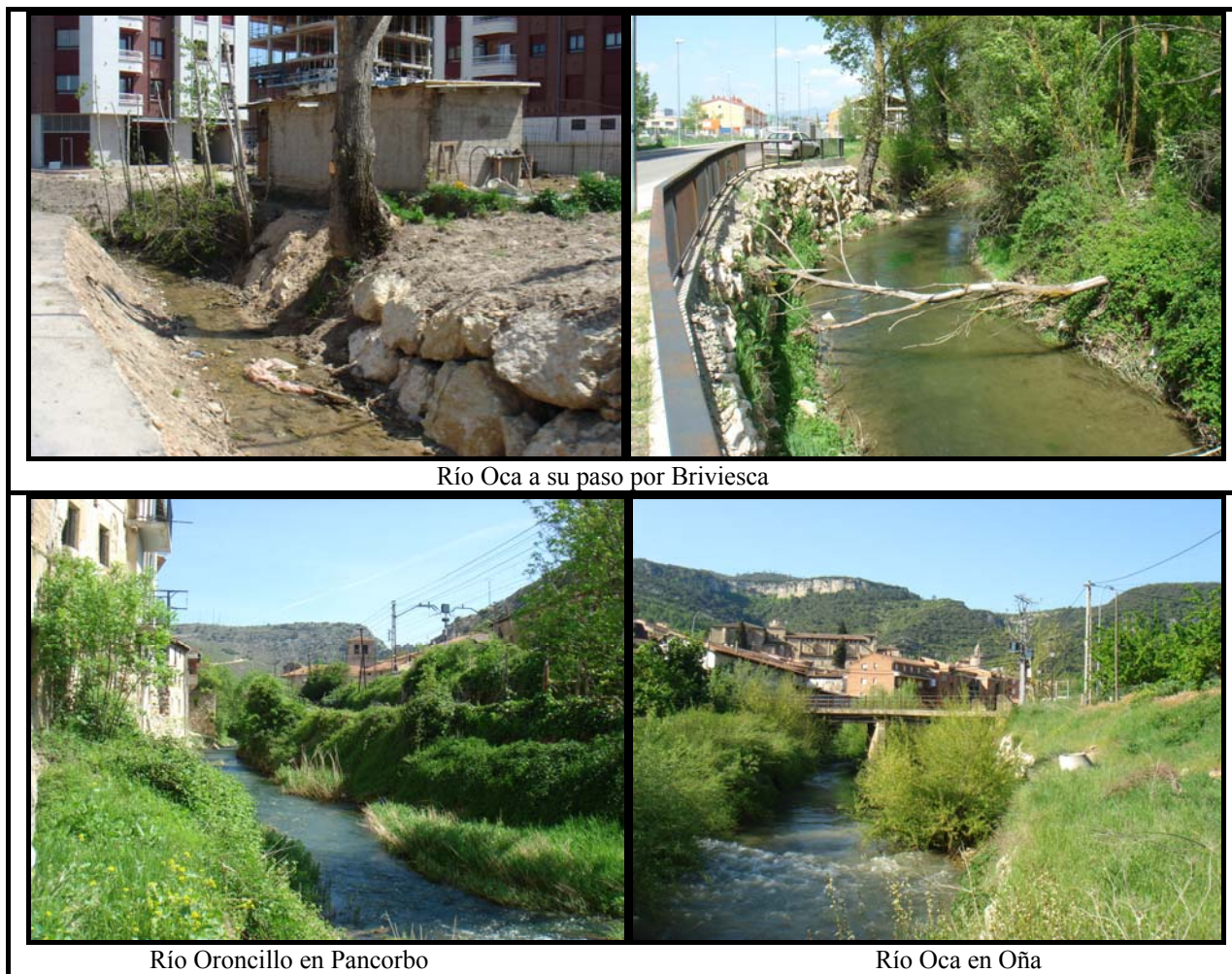
Figura 40: Algunos de los numerosos ejemplos existentes en la zona de la cuenca del Ebro en estudio; infraestructuras y edificaciones en zonas urbanas con potenciales riesgos de inundación por la proximidad a los cauces de los ríos.
