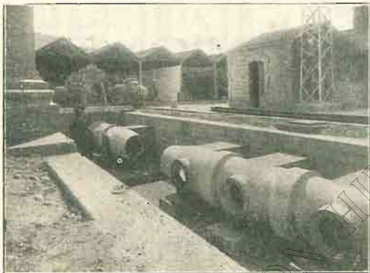
Colector de 1,00 m. con injertos de 0,50 m. Presión 12 kg./cm 2
