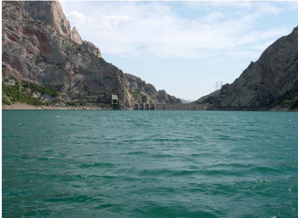
Vista de la presa desde la estación de muestreo (E1). Verano de 2005 (27/07/2005)
